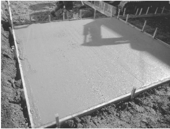
写真-11 施工中の状況
