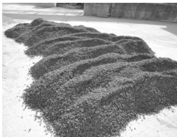
写真-6 敷き均し状況
