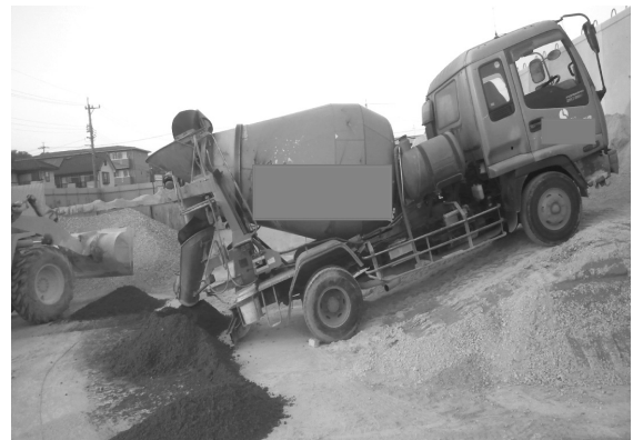
写真-4 10%勾配の状況
